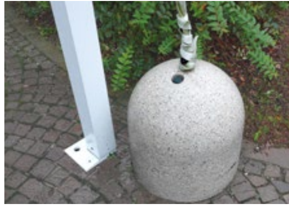
ANCORAGGIO zavorra in cemento
