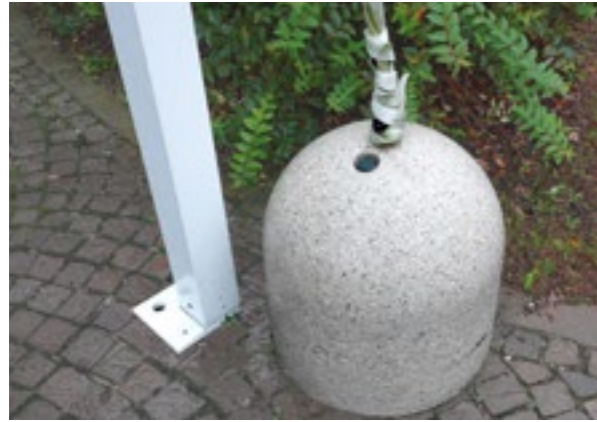
Anchorage Betonblock als Ballast
